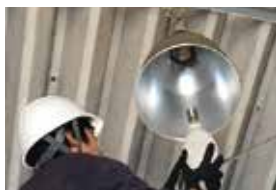
②水銀灯取り外し
